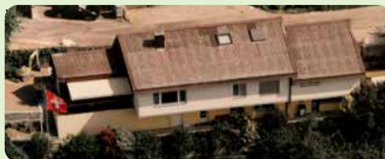
Das Haus aus den 70er-Jahren, das zum Haus der Zukunft werden soll.
