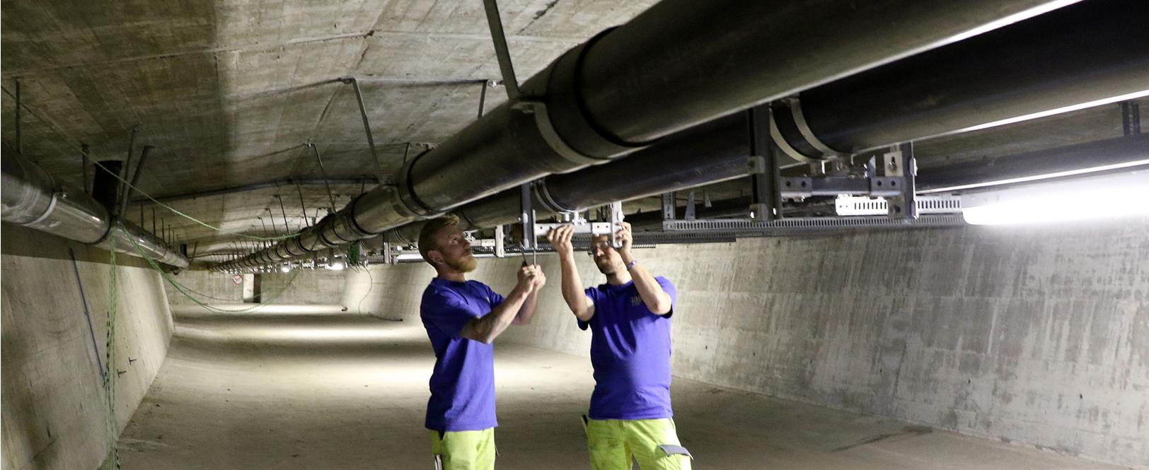
Wir verlegen für Sie Rohrleitungssysteme für die Wasserversorgung in allen Nennweiten und Druckstufen bis max. 16 bar in Werkstoffen aus Guss und Kunststoff (PE). Dabei übernehmen wir sämtliche Montage- und Installationsarbeiten bis und mit dem Hausanschluss. Zur Qualitätssicherung prüfen und protokollieren wir alle neu verlegten Leitungen auf ihre Dichtheit.
