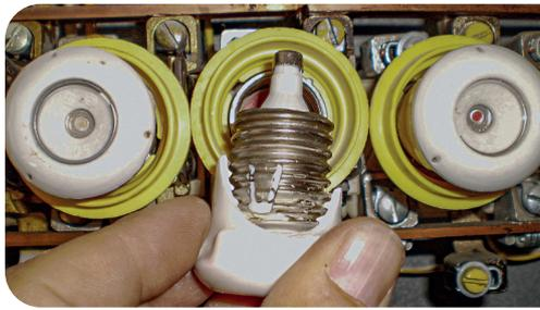
Beschädigter oder defekter Sicherungskopf.
