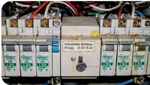
Oxidisierte Sicherungsautomaten oder Sicherungen in Verteilerkästen.
