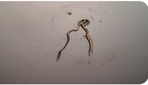
Nicht isolierte Drähte für den Anschluss von Deckenlampen.
