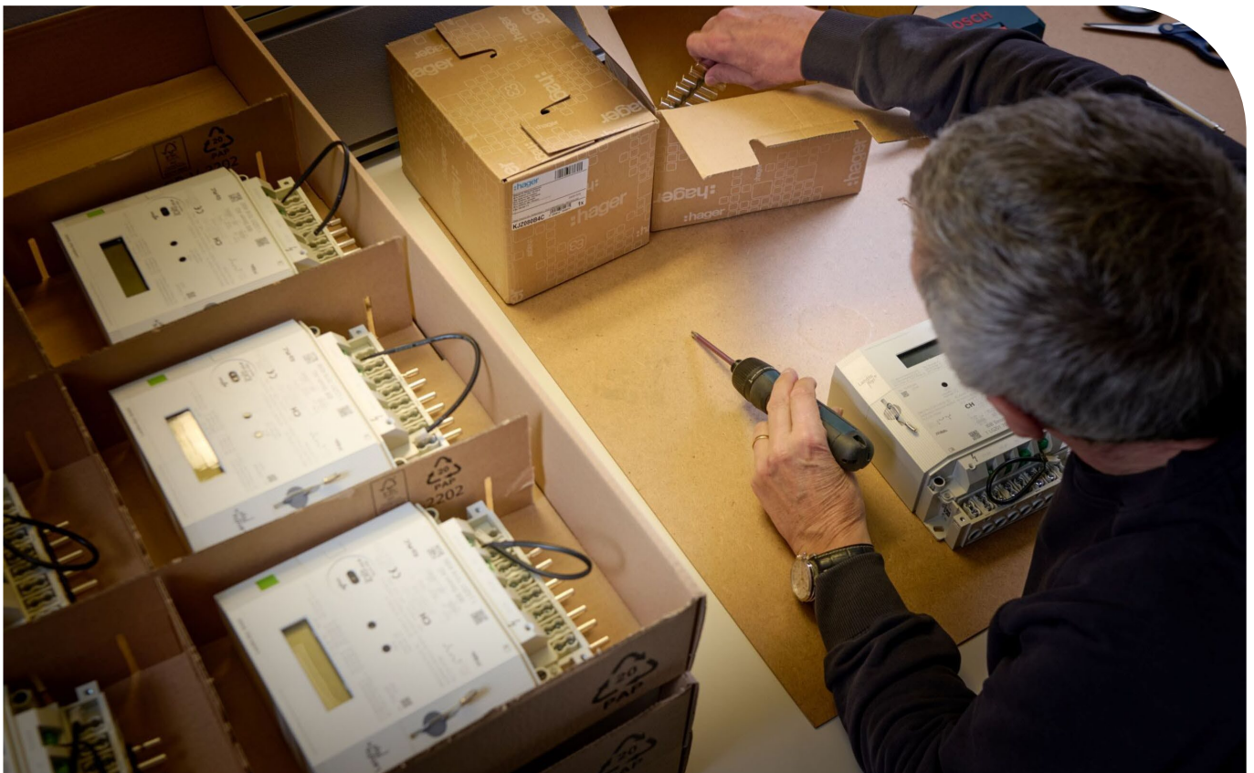
Smart Meter werden für den Einbau vorbereitet
