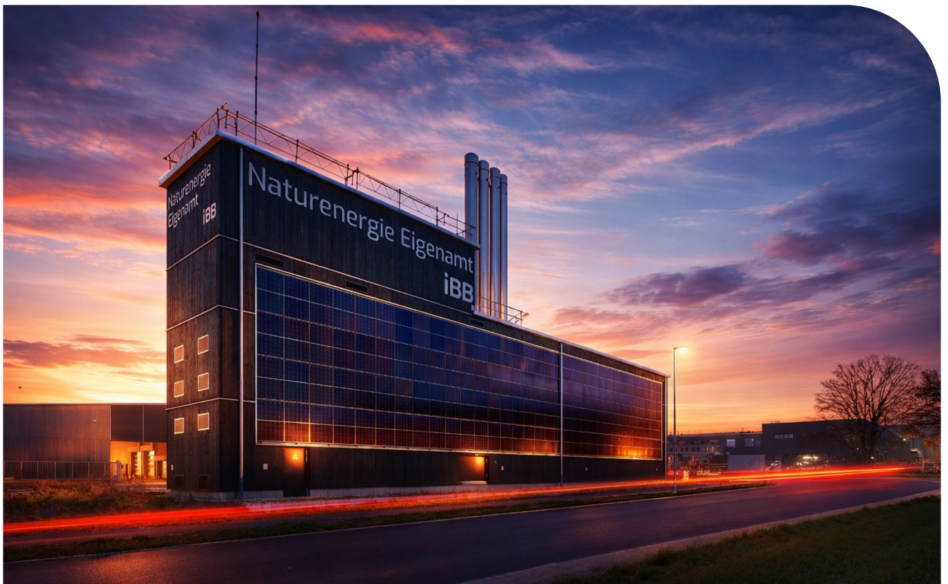
Energiezentrale Naturenergie Eigenamt
