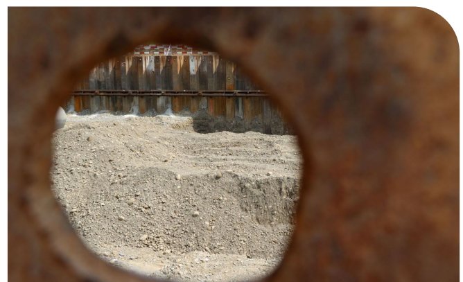
Baustelle Energiezentrale Campus Reichhold
