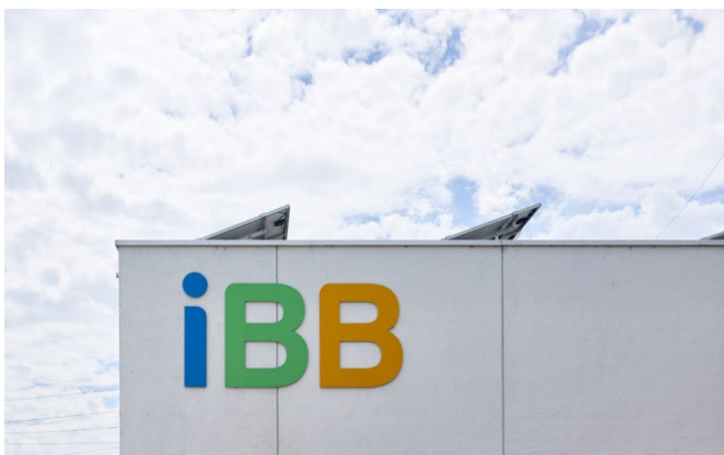
IBB-Unterwerk in Lupfig
