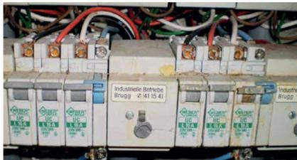
Oxidisierte Sicherungsautomaten oder Sicherungen in Verteilerkästen.
