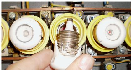
Beschädigter oder defekter Sicherungskopf.
