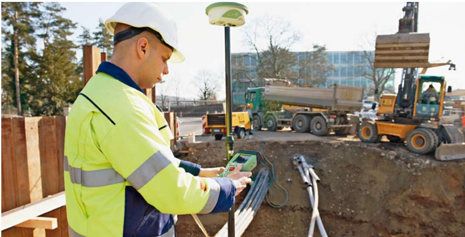
Ralf Bosch, Projektleiter IBB, beim Einmessen einer Werkleitung.
